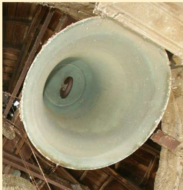
Photographiée en 2005, lors des travaux de réfection de la couverture du dôme du clocher.
