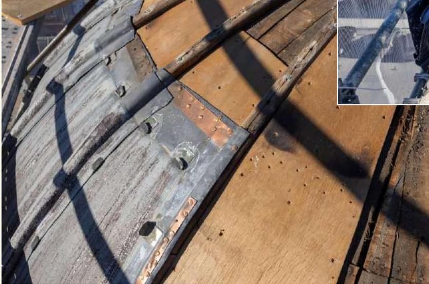
Toutes les plaques et la volige ont été déposées. La structure de la charpente de la coupole est maintenant visible.
